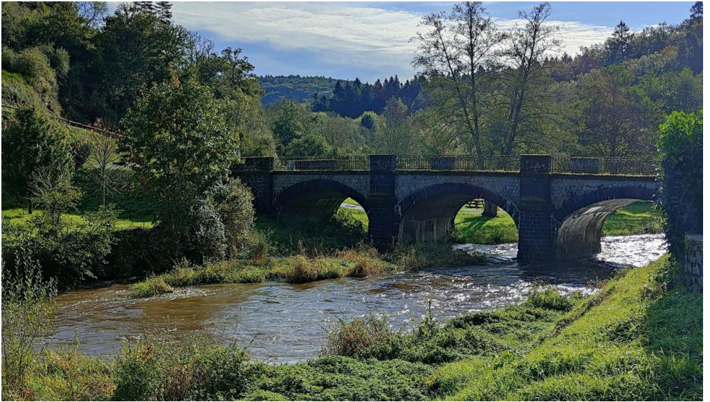
Le pont de Montfermy
